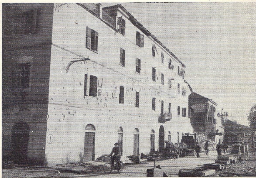
c) La facciata dello Stabilimento «Pernigotti» in via Mazzini dopo il bombardamento.
